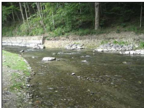
Effacement complet d'un ouvrage type déversoir sur le Bocq (Sinbio : 2011)
