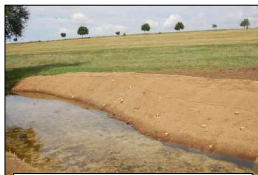
Illustration des couches de branches à rejets de Saules sur le Longeau
