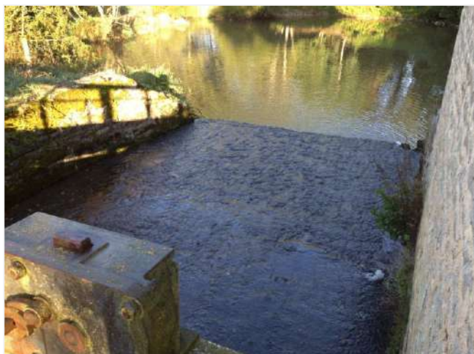
Illustration du radier de l'ouvrage de Gondras (OH1). En cas de suppression des vannages, la chute résiduelle reste un frein pour la mobilité piscicole.
