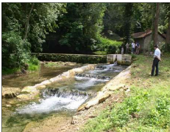
Création d'un dispositif de type pré barrage à Chatillon sur Seine (Sinbio : 2010)
