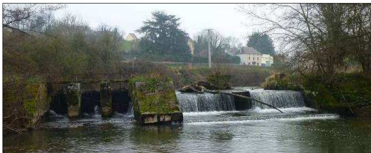
Le seuil de répartition du bief (parties fixe et mobile)
