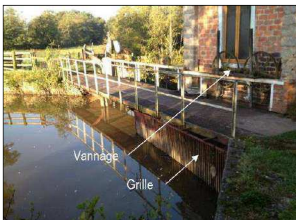
Vue amont du seuil du moulin
