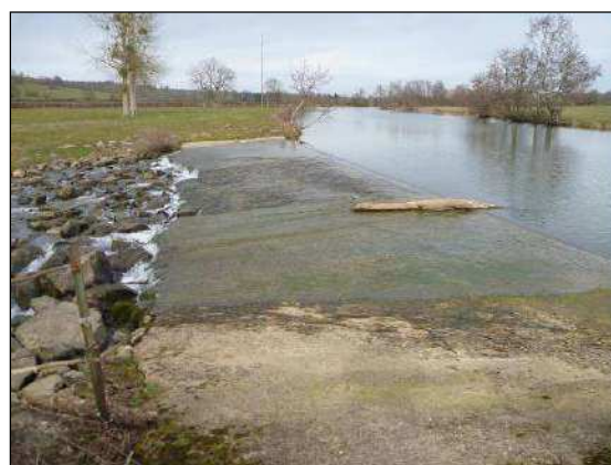
Vue au droit du seuil répartiteur
