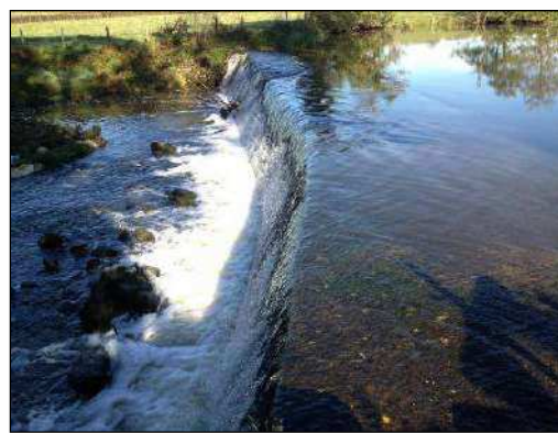
Vue au droit du seuil
