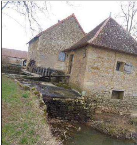
Seuil déversoir secondaire
