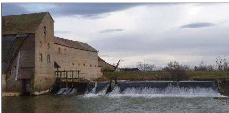
Vue aval de l'ouvrage
