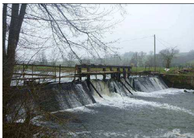
Vannage et seuil déversoir – Rive Gauche
