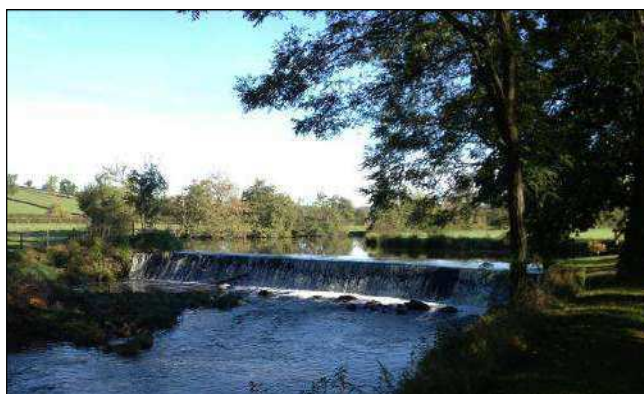
Seuil déversoir en tête de bief
