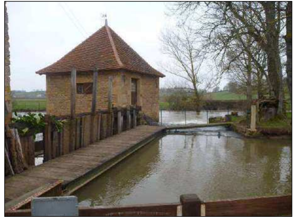
Vannes de décharge au droit du moulin
