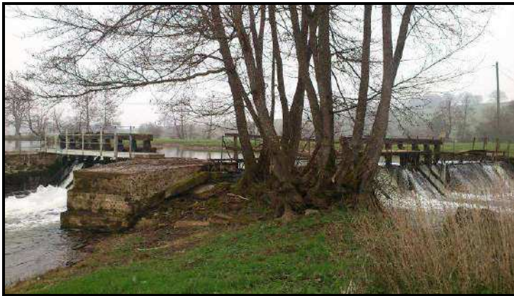
Vue d'ensemble de l'ouvrage
