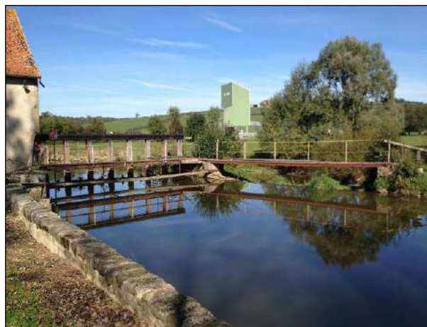
Vannes de décharge au droit du moulin et seuil secondaire
