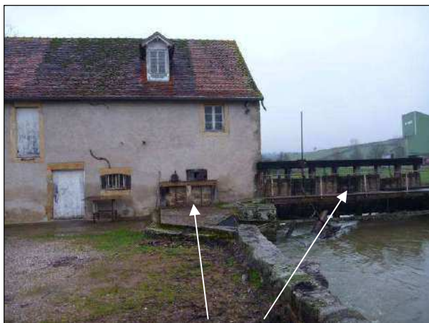
Vannes motrices et vannes de décharges
