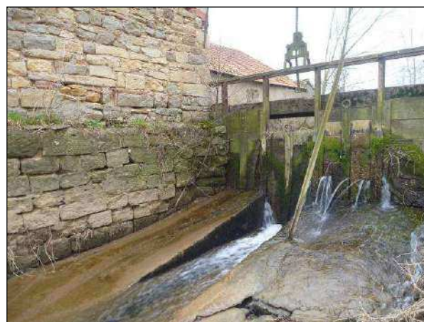
Vue aval du vannage en droit du moulin
