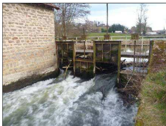
Vue aval du seuil du moulin
