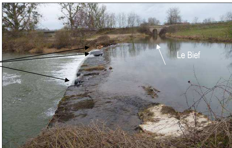
Vue au droit du seuil
