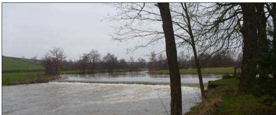
Conditions proches de l'effacement du seuil – Photo 20/02/2013 Crue<Q1an (9,8 m 3 /s)
