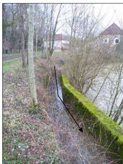
Prise d'eau non utilisée
