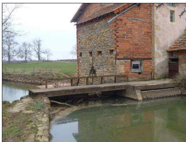
Vue amont du vannage au droit du moulin
